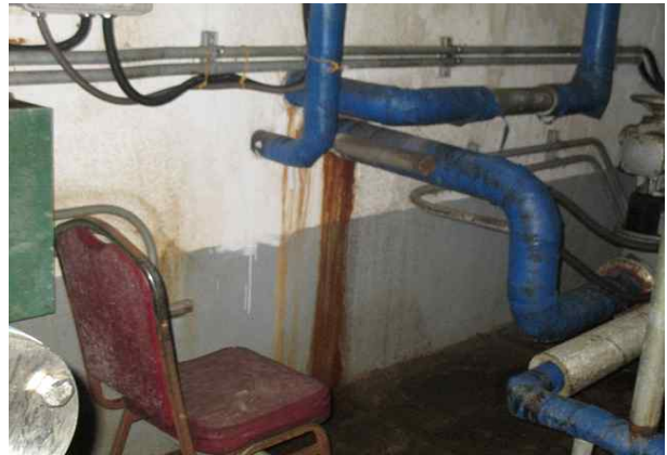
사진번호 14 위치 내부 지하층 벽체
