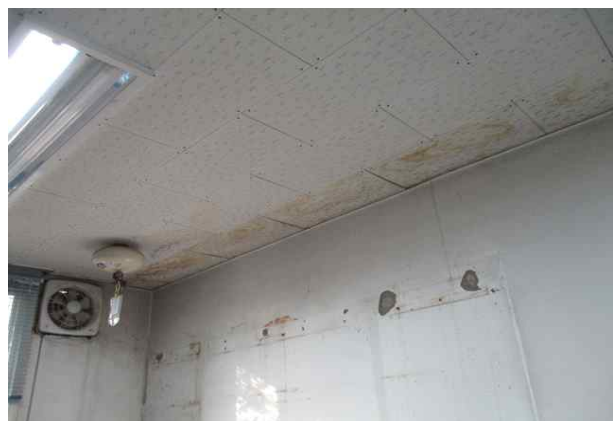
사진번호 24 위치 내부 천장 내 용 누수흔적 (A=5.0m×0.5m)
