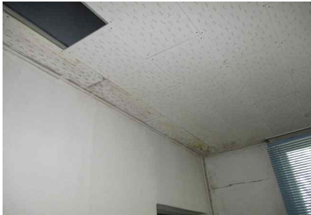
사진번호 19 위치 내부 천장 내 용 누수흔적 (A=3.0m×0.3m)
