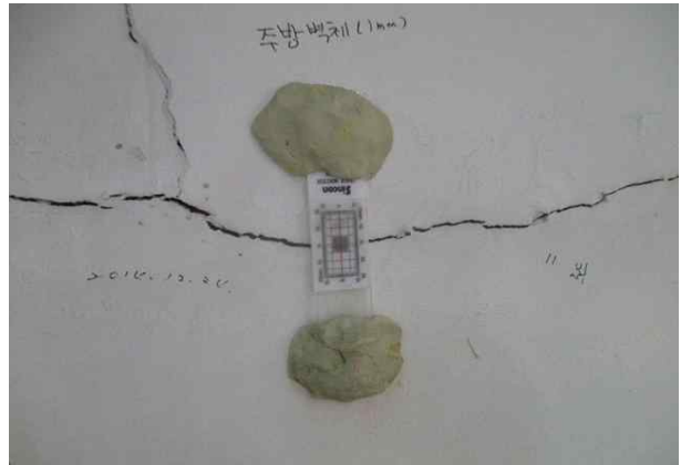
사진번호 20 위치 내부 벽체 내 용 균열 (CW=1.0mm, L=1.0m)
