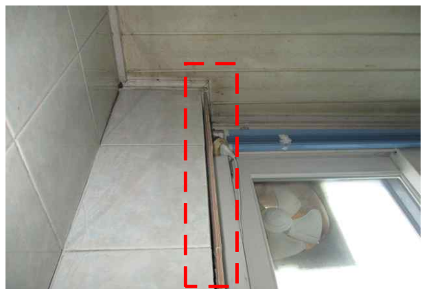
사진번호 18 위치 내부 화장실 벽체
