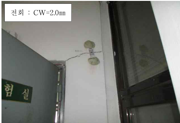
사진번호 21 위치 내부 벽체 내 용 균열 (CW=3.0mm, L=0.5m)
