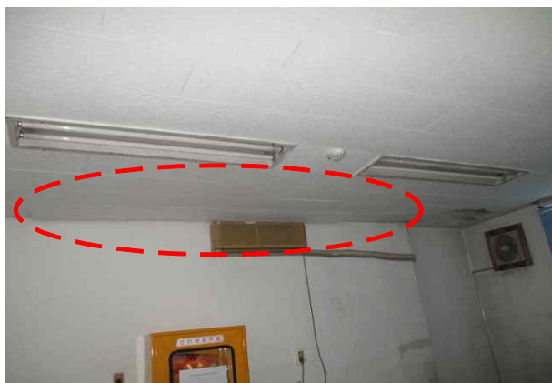
사진번호 23 위치 내부 천장 내 용 마감재 변형 (A=5.0m×1.0m)
