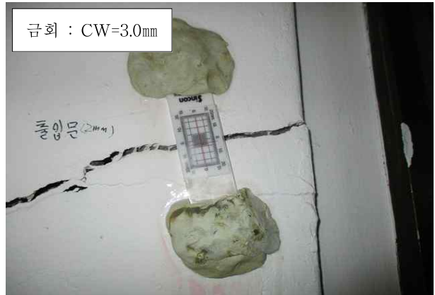
사진번호 22 위치 내부 벽체 내 용 균열 (CW=3.0mm, L=0.5m)
